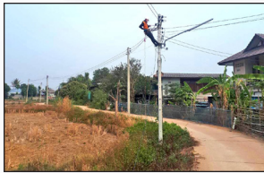
โครงการขยายเขตไฟฟ้าสาธารณะพร้อมติดตั้งโคมไฟกิ่ง ซอย 6 หมู่ที่ 3 บ้านแม่กาหลวง
