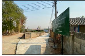
โครงการก่อสร้างถนนคอนกรีตเสริมเหล็ก (ค.ส.ล) จำนวน 2 ช่วง หมู่ 2
