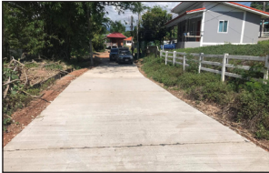
โครงการก่อสร้างถนนคอนกรีตเสริมเหล็ก ภายในหมู่บ้าน ขอย 1 (หอพักวิโรจน์) หมู่ 16
