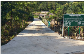
โครงการก่อสร้างถนนคอนกรีตเสริมเหล็ก ภายในหมู่บ้าน ขอย 3 หมู่ 18
