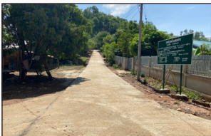
โครงการก่อสร้างถนนคอนกรีตเสริมเหล็ก ภายในหมู่บ้าน ขอย 4, 5 หมู่ 18
