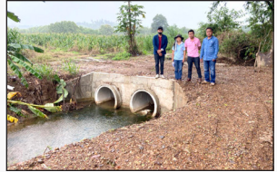
โครงการวางท่อระบายน้ำคอนกรีตเสริมเหล็ก หมู่ 1
