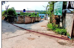
โครงการก่อสร้างฝายปัดรางระบายน้ำ ขอย 3 หมู่ 2
