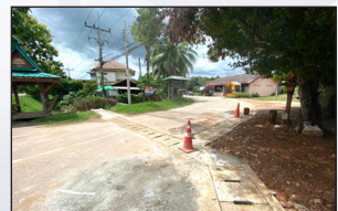
โครงการก่อสร้างรางระบายน้ำคอนกรีตเสริมเหล็ก รูปด้วยพร้อมฝายปิด ขอย 3 หมู่ 11
