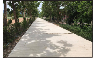
โครงการก่อสร้างถนนคอนกรีตเสริมเหล็ก ขอยบ้านลุงสอน หมู่ 15
