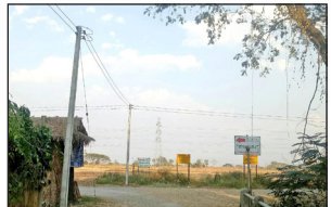
โครงการขยายเขตระบบจำหน่ายไฟฟ้าแรงต่ำ บ้านแม่ตำบลบุญโยง ซอย 3 หมู่ที่ 11
