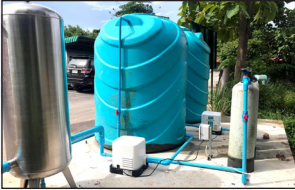
โครงการปรับปรุงระบบประปา สำนักงานเทศบาลแม่กา
