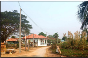
โครงการขยายเขตระบบจำหน่ายไฟฟ้าแรงต่ำ บ้านห้วยเคียน ซอย 4 หมู่ที่ 2
