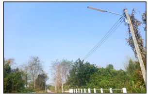
โครงการขยายเขตระบบจำหน่ายไฟฟ้าแรงต่ำ ไฟฟ้าสาธารณะ ซอย 1 หมู่ที่ 5 เชื่อม หมู่ที่ 9 บ้านแม่ตำบลบุญโยง
